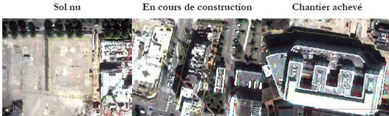
Les étapes d'un chantier de construction
